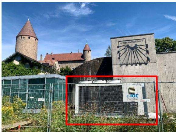
Figure 24 Climatisation de secours installée à l'extérieur ©He-Arc CR, Jasmine Praz, 2024
